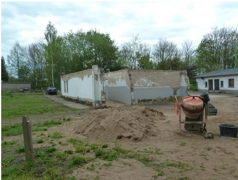
Foto 1: Rückbau der ehemaligen Bäckerei
