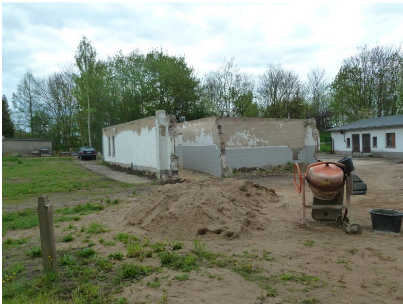
Foto 1: Rückbau der ehemaligen Bäckerei
