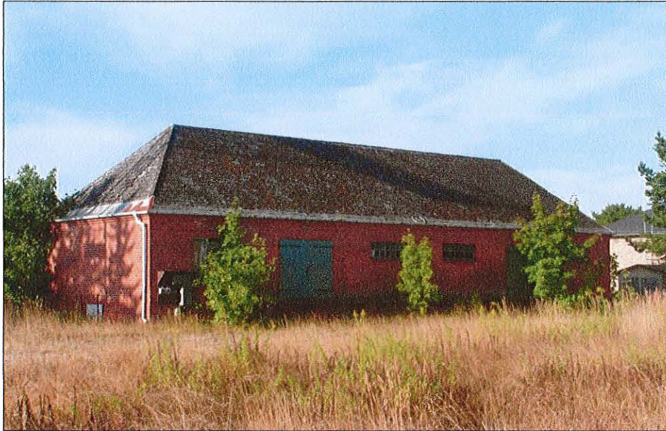
Abbildung 5: Ansicht des ehemaligen Lagergebäudes
