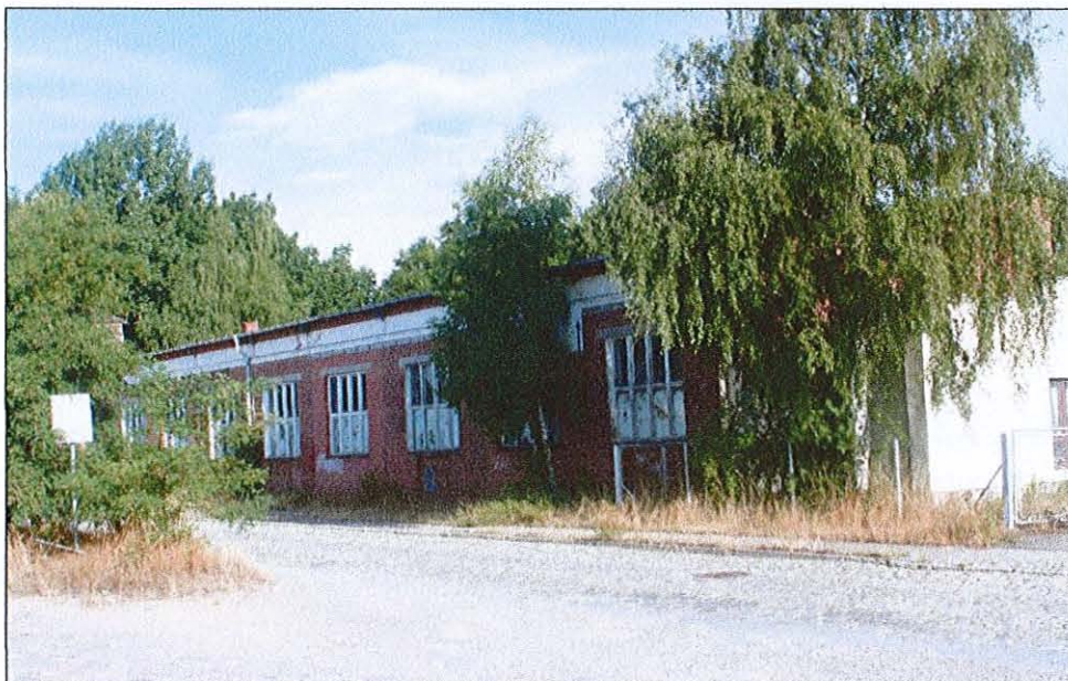
Abbildung 6: Ansicht der ehemaligen KFZ-Werkstatt
