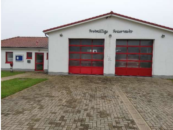
Abbildung 13 Gerätehaus FF Testorf-Steinfurt
