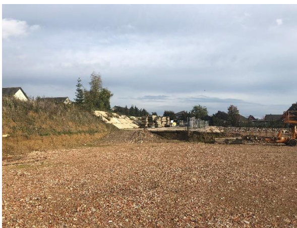
Vorgesehene Fläche für neue Lagerhalle
