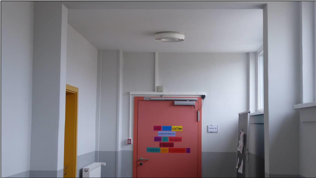
Abb. 4: Blick in den Innenraum eines der Schulgebäude. Alle Fenster sowie Außenmauern sind intakt und bieten keinen Raum oder Hinweis für potenzielle Quartiere geschützter Tierarten.
