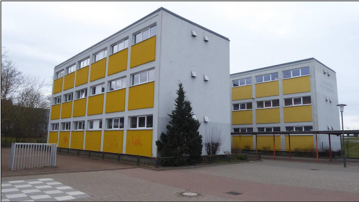
Abb. 2: Eines der zwei Schulgebäude, welches abgerissen wird (alle Fotos vom 30.03.2021).
