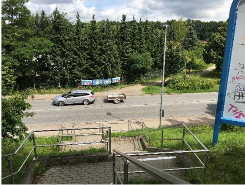
Treppenzugang von der B 105 ohne Rampe
