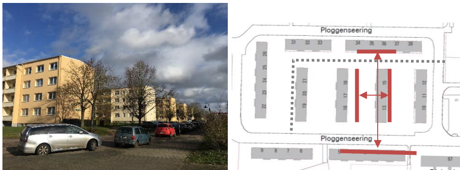
Abstände der Gebäude Hausnr. 1 - 38; Nord-Süd (a): 93 m, Ost-West (b) 27m
