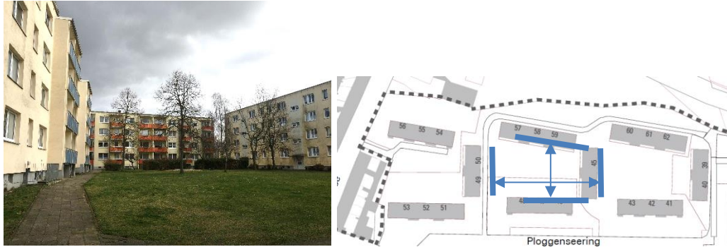
Abstände der Gebäude Hausnr. 39-50; Nord-Süd (a): 31-39m, Ost-West(b): 63-69m
