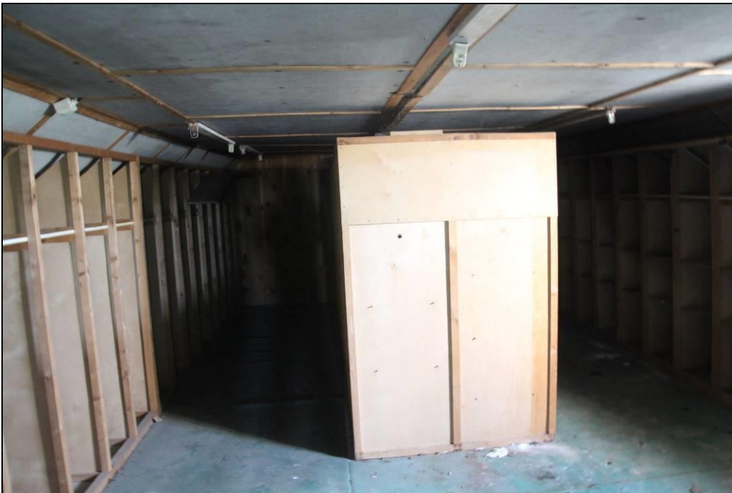
Abbildung 7: Innenräume im Dachgeschoss des ehemaligen Verwaltungsgebäudes
