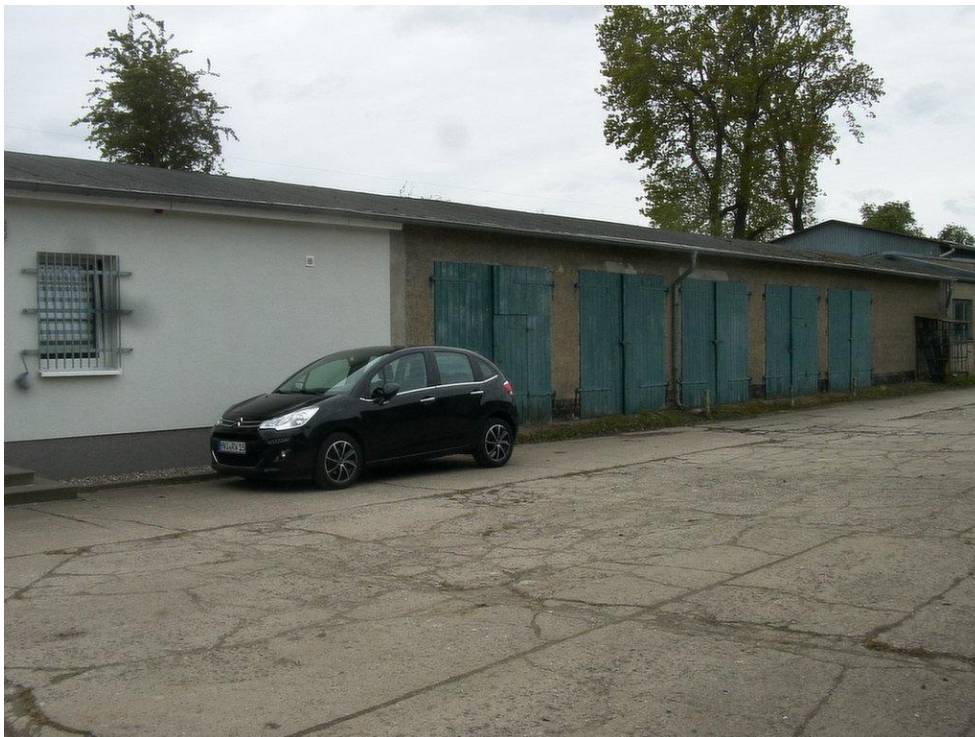
Bild 5.1 Nordseite Gebäude G1.
