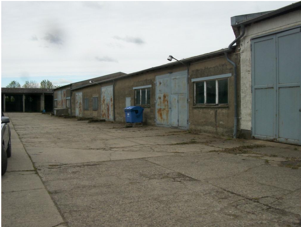
Bild 6.1 Westflügel, Südseite Gebäude G2.
