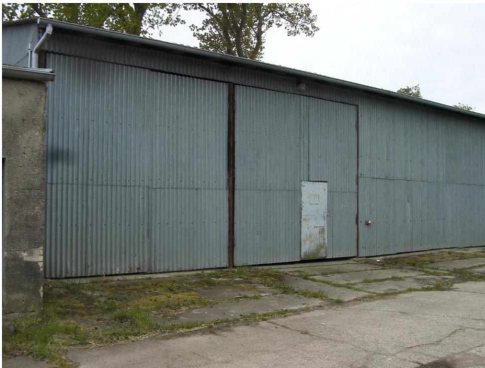
Bild 7.1 Nordseite Gebäude G3
