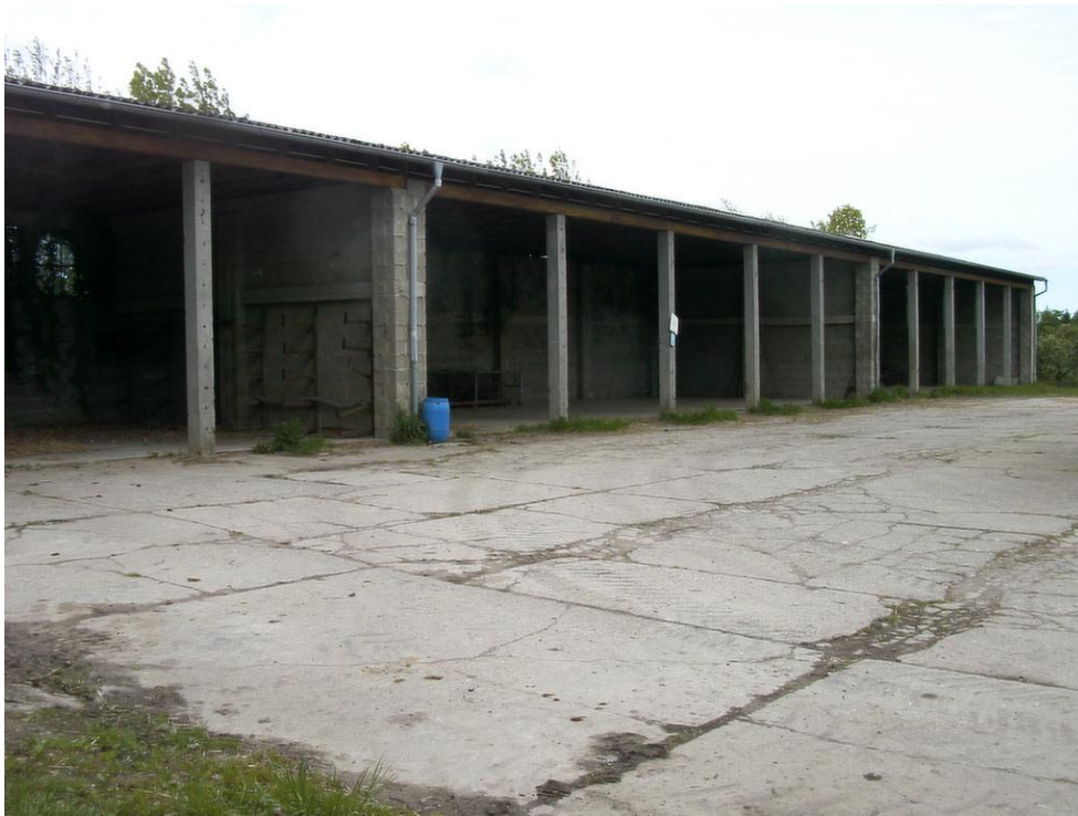
Bild 8.1 Ostseite Gebäude G4.
