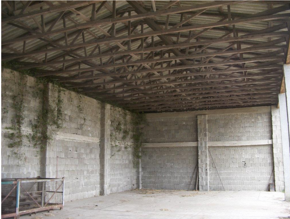
Bild 8.2 Innenseite Gebäude G4.
