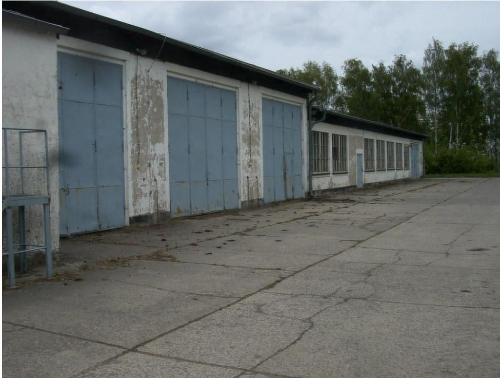
Bild 6.2 Ostflügel, Südseite Gebäude G2
