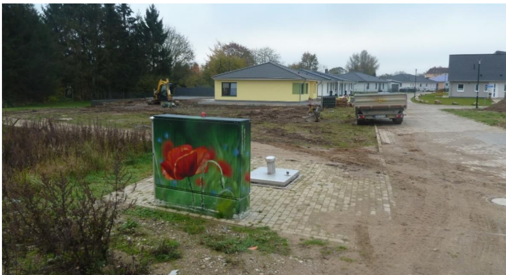
Bild 3: Anschluss an vorhandene Erschließung Straße „Am Walkmühlengraben“
