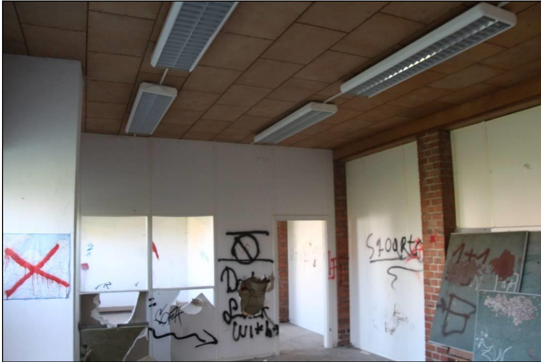
Abbildung 6: Innenräume des ehemaligen Verwaltungsgebäudes
