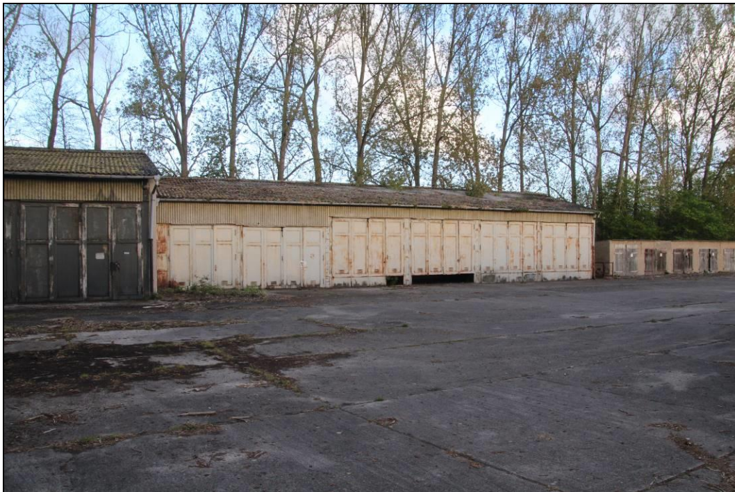
Abbildung 9: Garage in Richtung Nordwesten
