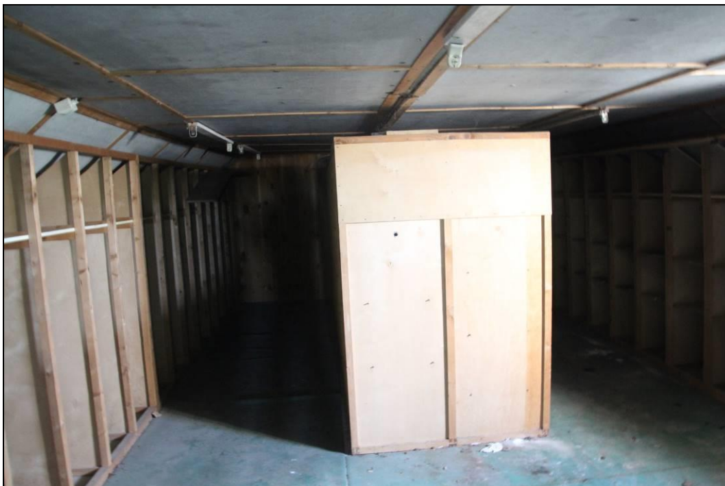
Abbildung 7: Innenräume im Dachgeschoss des ehemaligen Verwaltungsgebäudes
