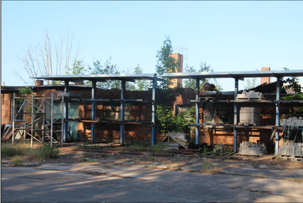
Abbildung 12: Regal auf der Freifläche
