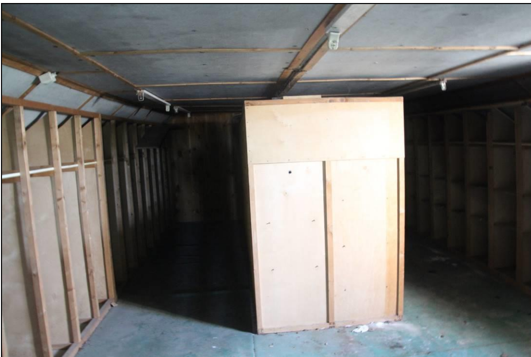
Abbildung 7: Innenräume im Dachgeschoss des ehemaligen Verwaltungsgebäudes
