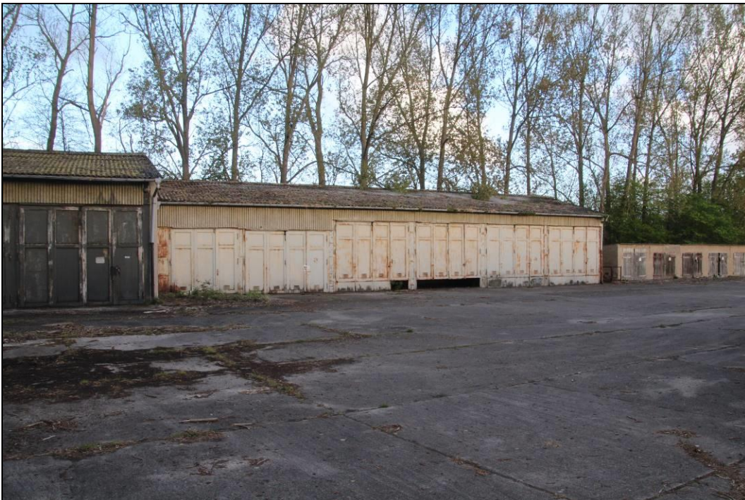
Abbildung 9: Garage in Richtung Nordwesten
