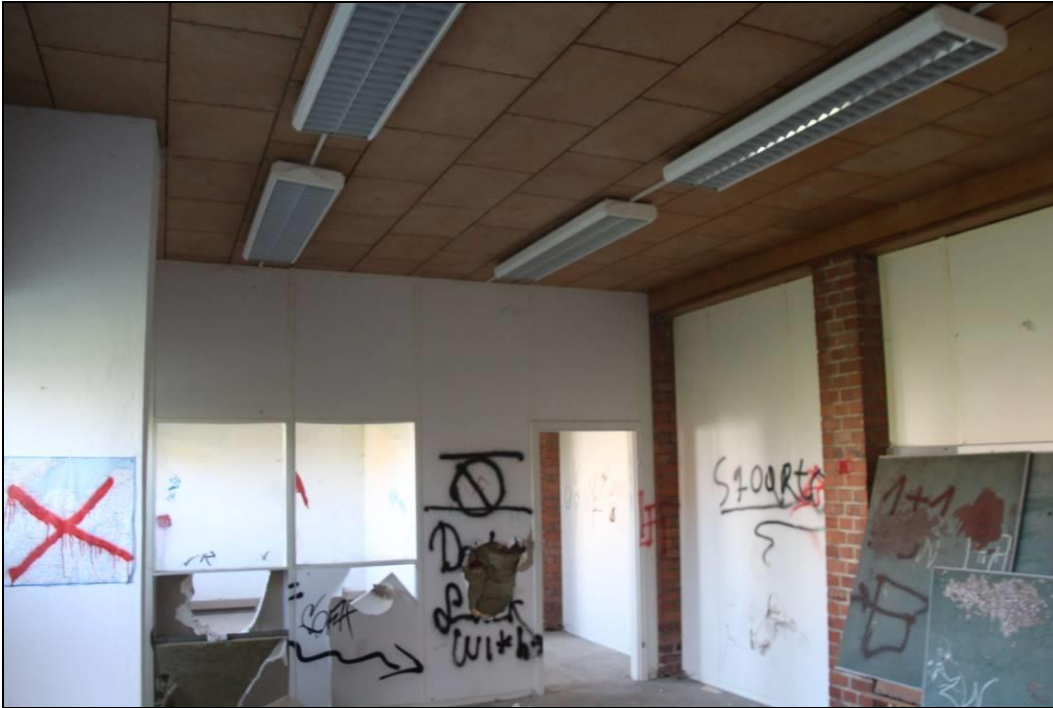
Abbildung 6: Innenräume des ehemaligen Verwaltungsgebäudes
