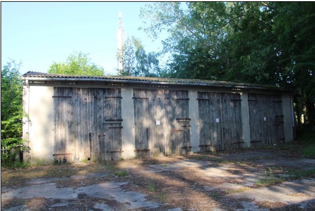
Abbildung 13: Garage im Südosten
