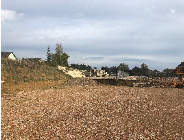
Vorgesehene Fläche für neue Lagerhalle
