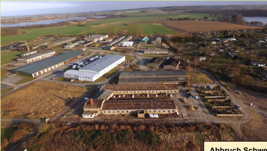
Abbruch Schweineställe Klützer Straße
