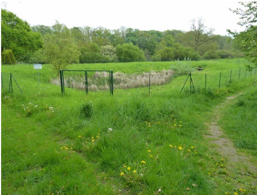
Bild 4.2.2 Regenrückhaltebecken auf Flurstück 4/216 – für Feuerlöschzwecke nicht nutzbar
