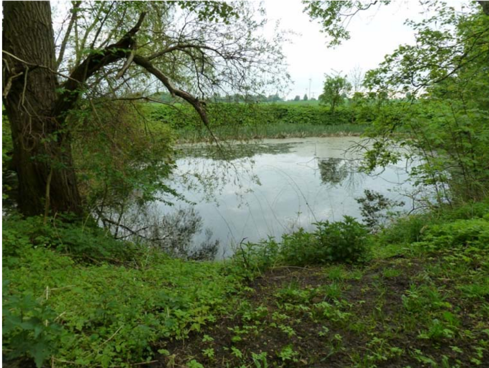
Bild 4.5.1 Löschwasserentnahmestelle auf Flurstück 59
