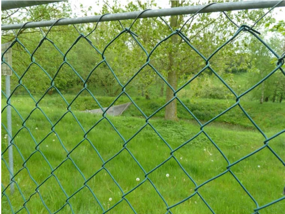
Bild 4.2.1 Regenrückhaltebecken auf Flurstück 25/1 – für Feuerlöschzwecke nicht nutzbar
