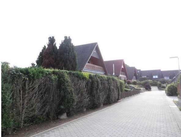
Angrenzende Wohnbebauung des Bebauungsplanes Nr. 5.
