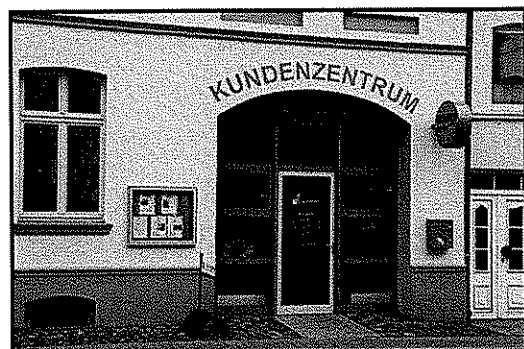
Wismarsche Straße 1 in Grevesmühlen
