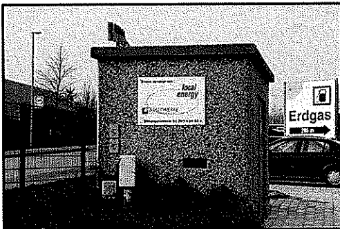
Gasdruckregelstation
