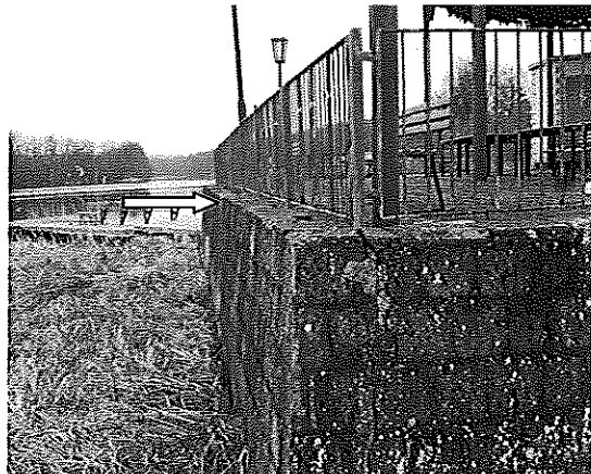
erreichbare Standfläche hinter der Brüstung
