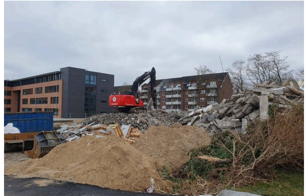
Abriss der alten Grundschulgebäude (02/2025)
