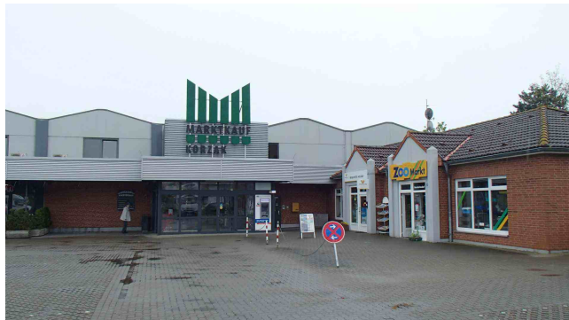
Marktkauf Korzak Klützer Straße. Flächengrößter Lebensmittelmarkt in Grevesmühlen. Älterer Baukörper, in- nen moderner Auftritt. Rückseitig separater Getränkemarkt.
