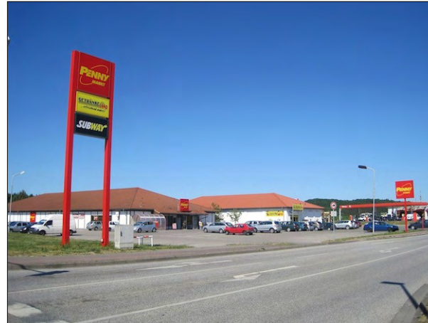
Verbundstandort Penny, Getränkeland und Subway; verkehrsorientierte Lage im Gewerbegebiet Ost (Grüner Weg/Wismarsche Straße)
