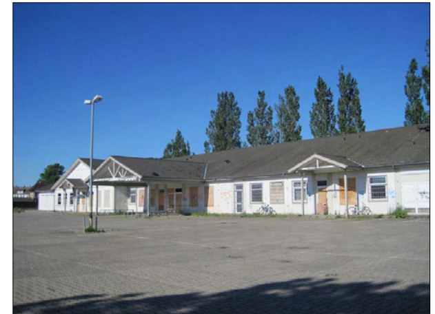
Südstadt: Leerstand ehem. Lidl / Schlecker Rehnaer Straße
