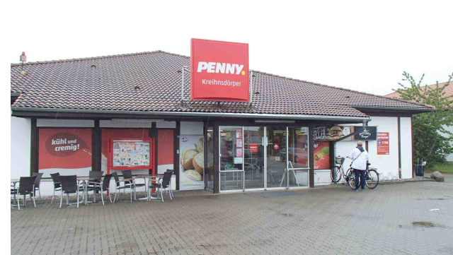
Penny Wismarsche Straße Bestandsobjekt: Untersuchungsvorha- ben, veralteter Markt- auftritt.
