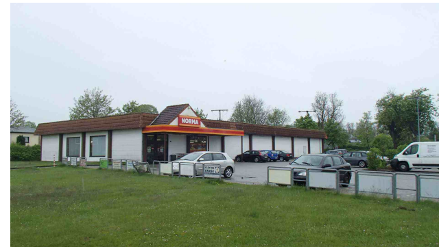
Norma Discounter Klützer Straße, vorgelagert zu Marktkauf; Veraltetes Objekt
