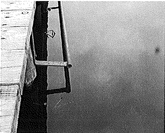
Querschnittsminderung an den Pfosten
