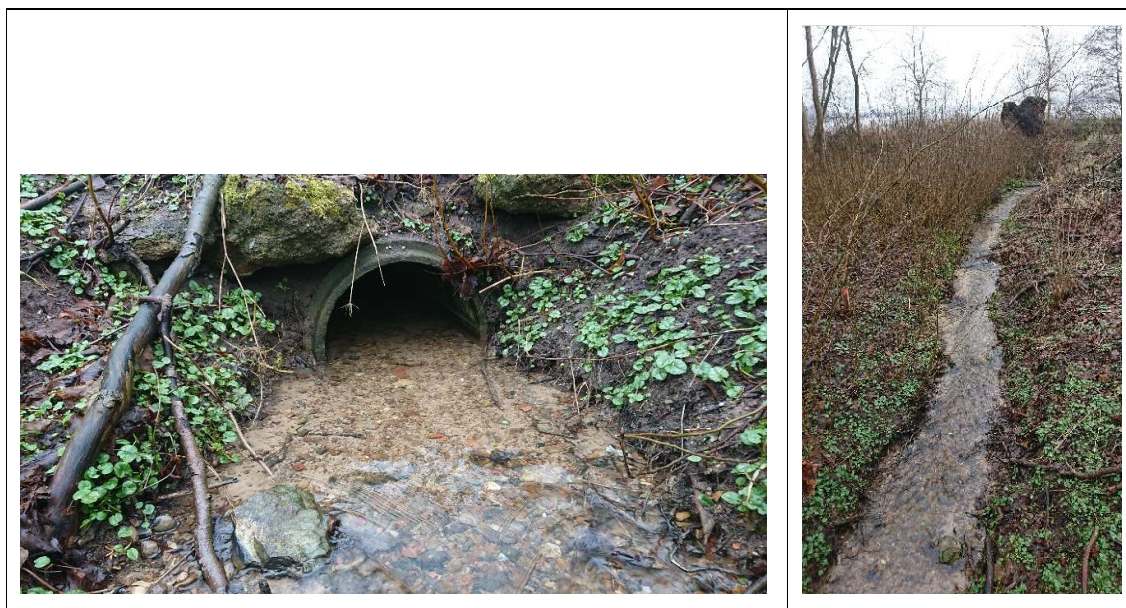
Abbildung 22: Graben War/9 (Probenstelle 4) am 14.02.2024 (Quelle: IaG GmbH)
