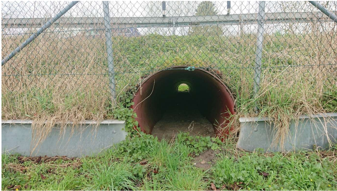
Abbildung 62: Fischotterpassage im Kreuzungsbereich des Grabens 22/6 mit der L 03 (Quelle: IaG GmbH).
