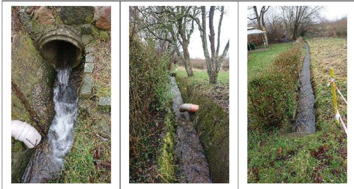
Abbildung 21: Graben War/8 (Probenstelle 5) am 14.02.2024 (Quelle: IaG GmbH)
