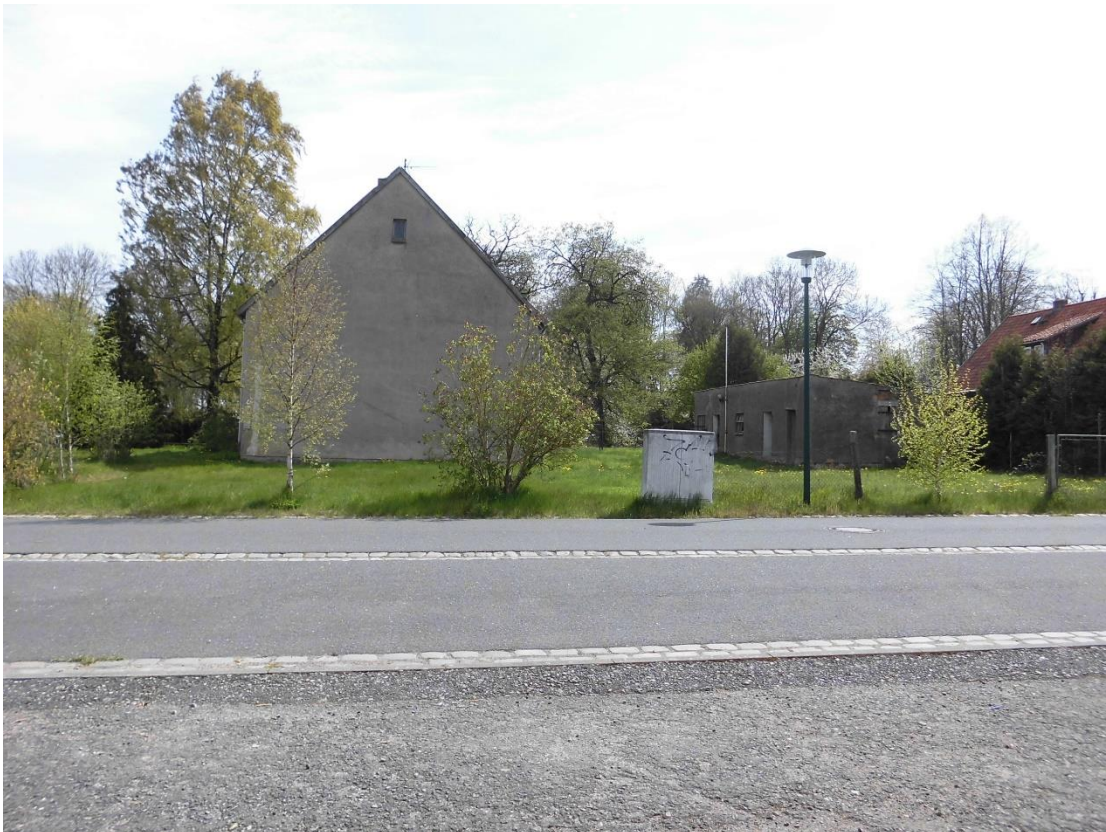
Abbildung 3: Zum Abbruch freigegebenes Wohngebäude mit Nebenanlage, diese weichen dem Museumsneubau (eigene Aufnahmen)
