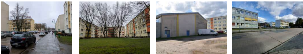
Abbildung 25: Bebauung des Ploggenseerings, links Wohnbauten, rechts Gemeinbedarfseinrichtungen
