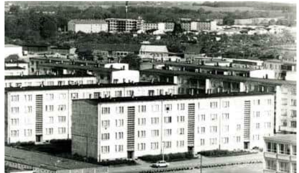
Abbildung 6: Geschosswohnungsbau aus den 1970er Jahren am Ploggenseering
