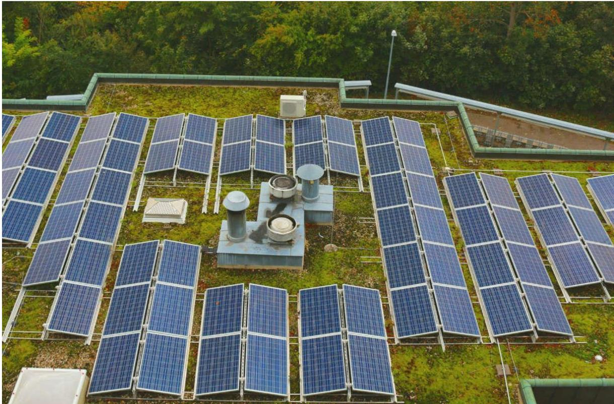
Abb. 10: Aufgeständerte PV-Anlagen auf einem Gründach, Quelle: <https://www.enbw.com/blog/energie-wende/solarenergie/photovoltaik-auf-dem-flachdach-geht-das/>
