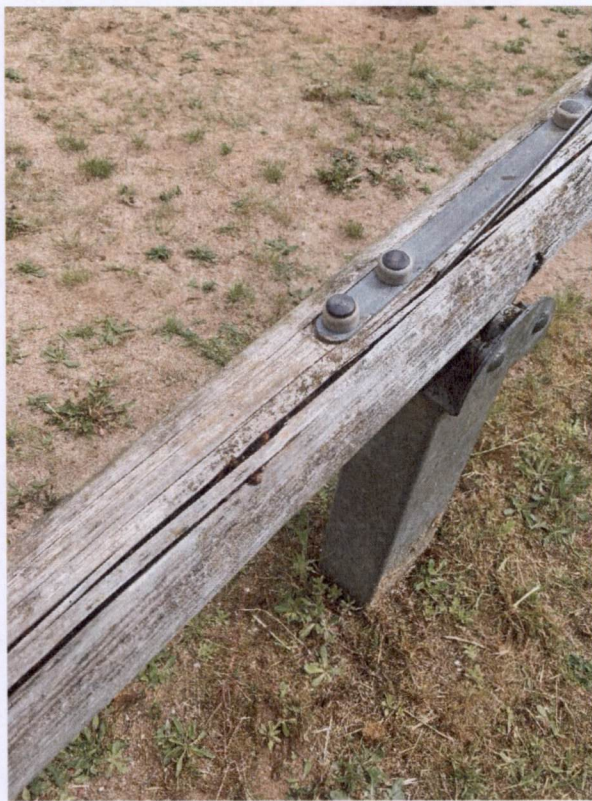
Pilzbefall, Querschnittsminderung
