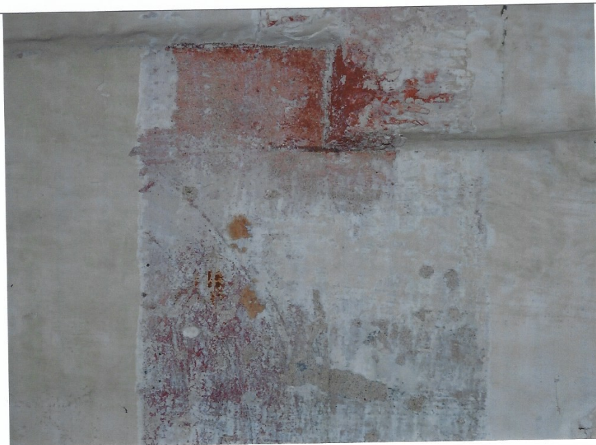
Foto 6 und 7; Südwand – Freilegungsprobe unten rechts, Bordüre und rotes Band entlang der Putzkante, liegt auch auf der Fase der Putzkante
