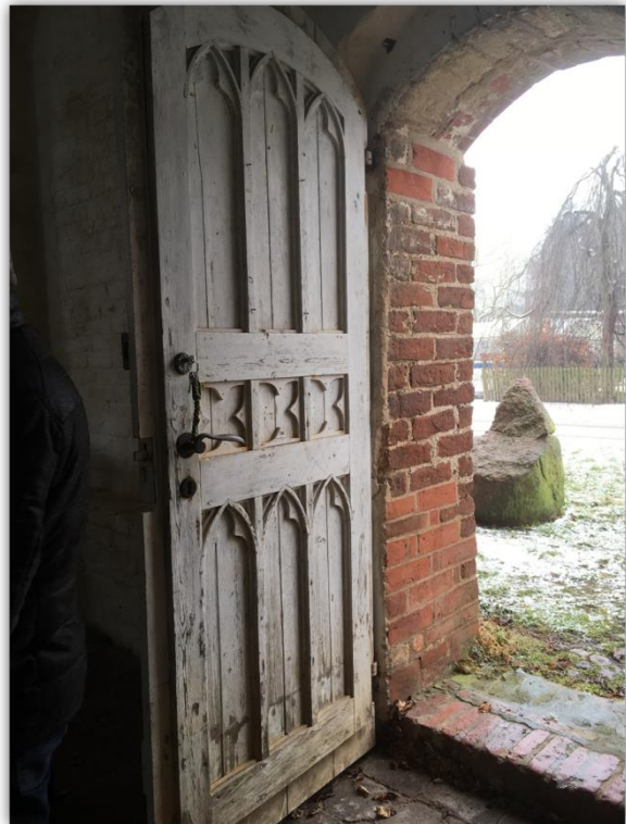
Tür mit Stichbogen
