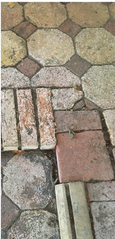
Detail diverse Steinbeläge salzbelastet
