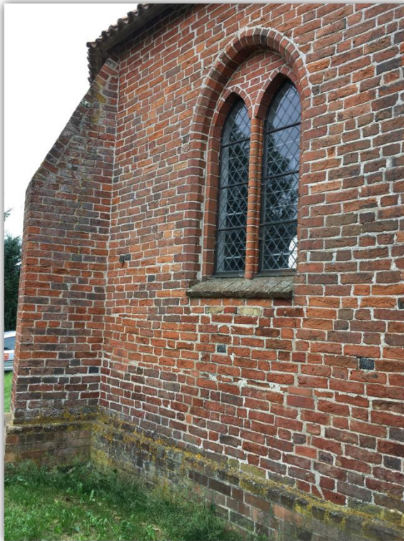
Geschädigtes Mauerwerk
