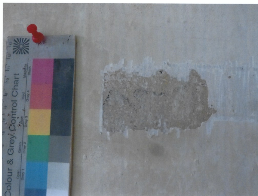
Foto 15 und 16; Nordwand – Freilegungsprobe am Teil eines Blattwerkes an einem Wappen
