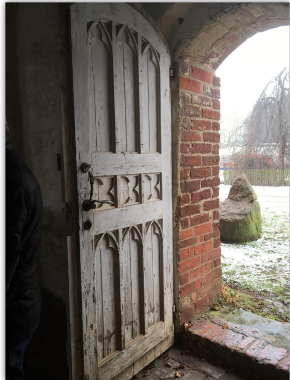
Tür mit Stichbogen
