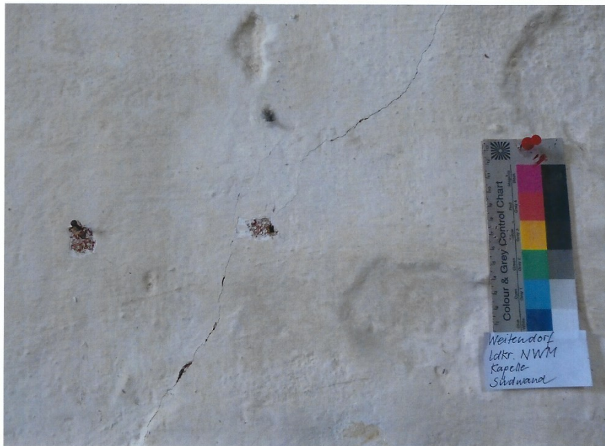
Foto 9 und 10; Südwand – Putz unterhalb des Fensters mit Sondierungspunkten, Befunde für eine dunkelrote Leimfarbe
