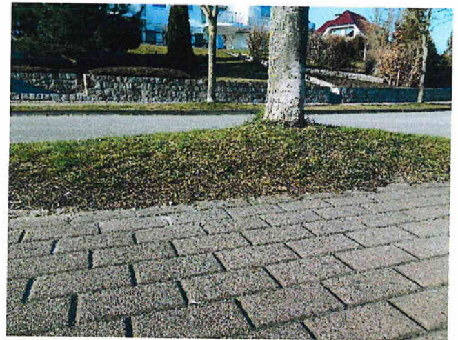
Abb.4: 9525 - Bodenaufwölbung
