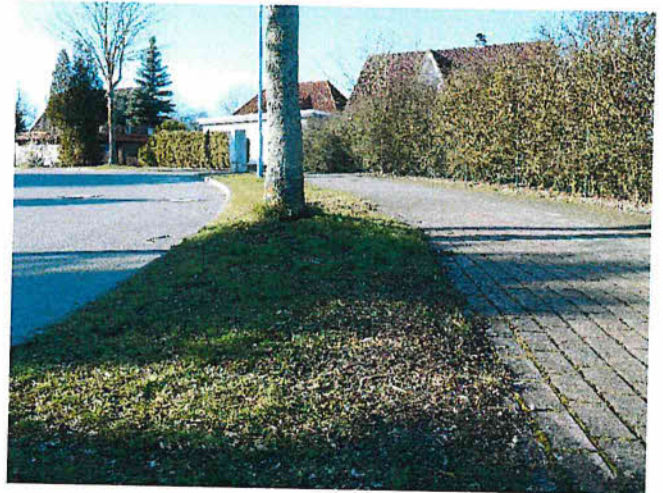
Abb.28: 9457 - Bodenaufwölbung
