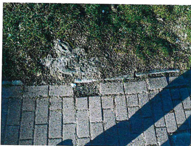
Abb.5: 9522 – Unebenheiten im Gehwegpflaster
