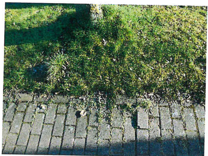
Abb.24: 9477 – Verwerfungen im Gehweg
