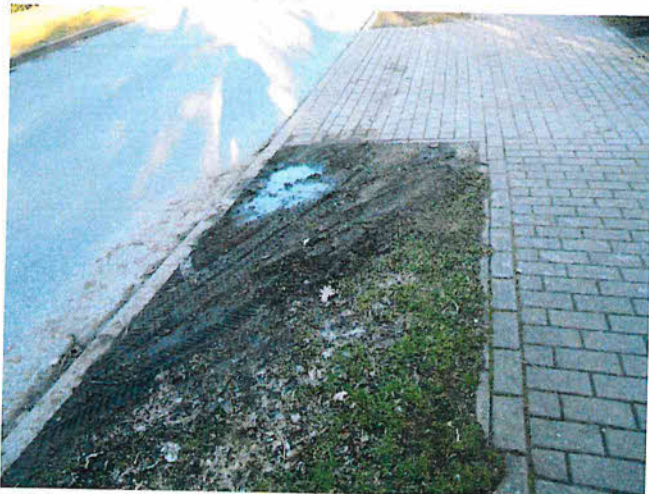
Abb.33: 9565 – Überfahrungen u. Verdichtungen des Pflanzstreifens
