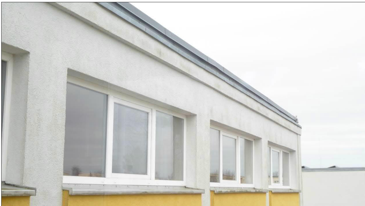
Abb. 3: Flachfach eines der Schulgebäude der Grundschule „Am Ploggensee“.
